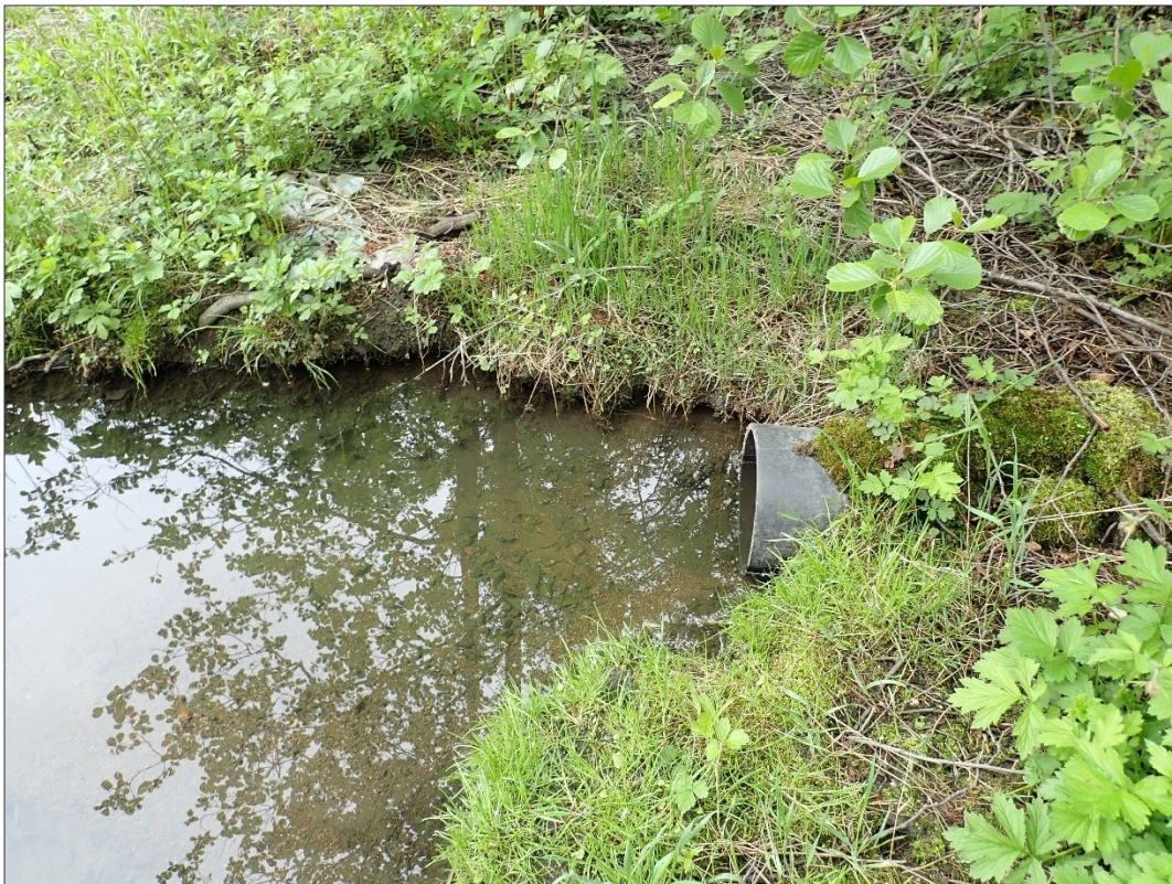
Kuva 8. Lampeen johtaa putki liittymäalueella kulkevien kevyenliikenteenväylien suunnasta (kuva otettu maastotarkistuksen yhteydessä 28.5.2019).
